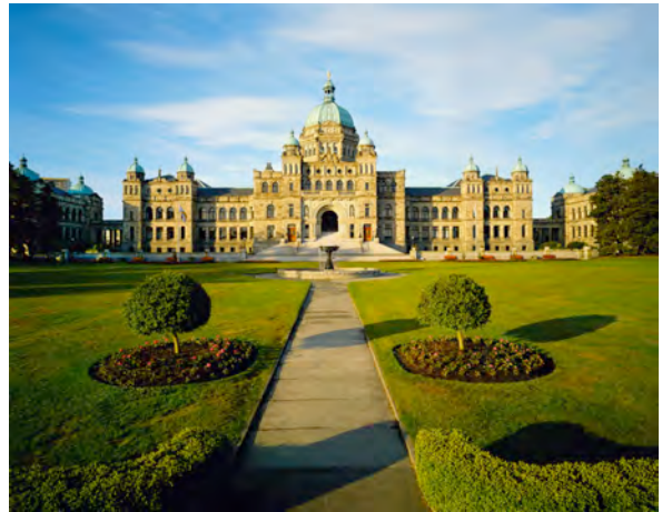
Bâtiments historiques du Parlement, Victoria (C.-B.)
